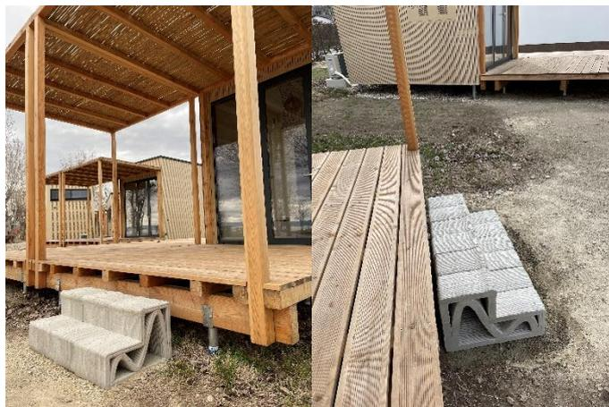
Abbildung 5. In Drainagemörtel versetzte Stufenelemente
